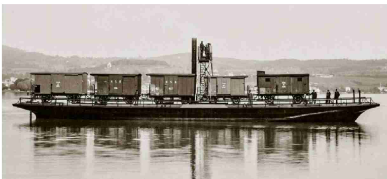
Die chemischen Stoffe wurden mit Trajektschiffen zwischen Wollishofen und Uetikon befördert. Rechts: 1910 waren zwei Dampflokomotiven für den internen Transport im Einsatz. Im Vordergrund wird Dünger in einen gedeckten Güterwagen eingeladen, die Lokomotive in der Mitte transportiert einen Kesselwagen mit Schwefelsäure.
